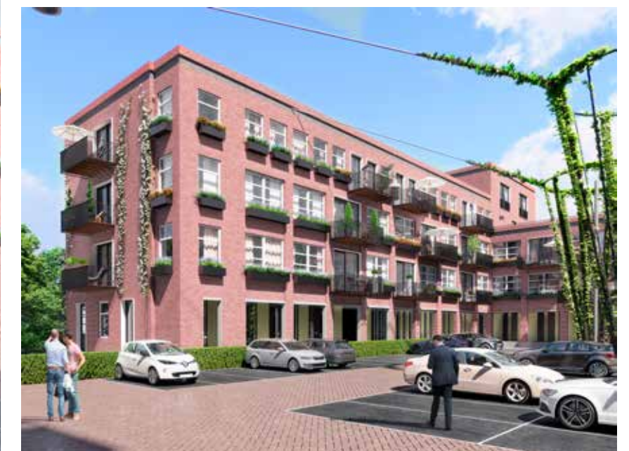
De ombouw van kantoorgebouw naar appartementen.
